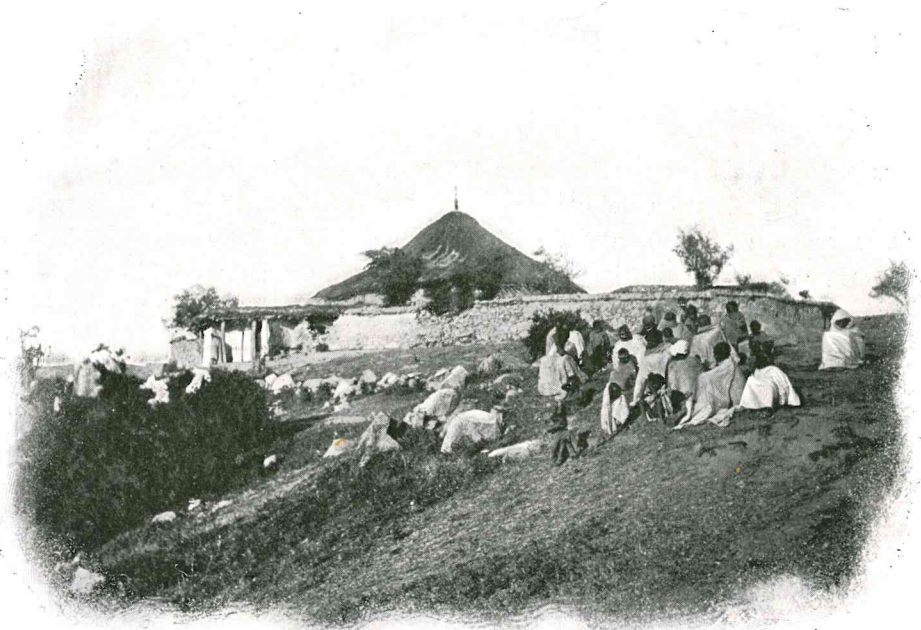
GLI ABITANTI DI AZ TECLESÀN MIRANO È PIANGONO L'INCENDIO DI AGOTRÌ.
